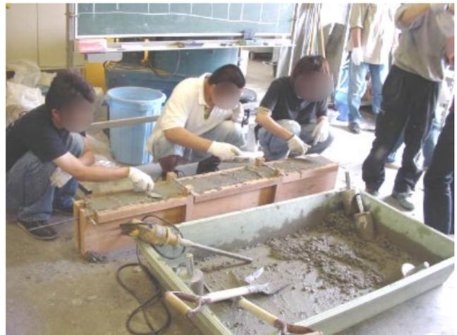
図 2 RC はりへのコンクリートの打設
